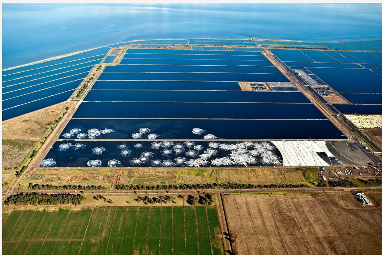
Hình 33: Nhà máy Xử lý Phía Tây
