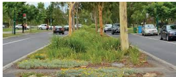
Hình 31: Mương lọc sinh học giữa hai con đường ở Lyndhurst
