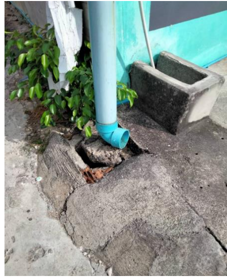
ภาพที่ 7 : ใบไม้และถังขยะวางท่อระบายน้ำบางส่วน (ซ้าย) และท่อน้ำทิ้งจากหลังคาที่ไม่ได้เชื่อมต่อกับระบบระบายน้ำ (ขวา)
